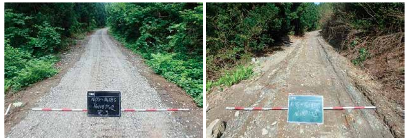
碎石入れても水分が浮き出てユルユルに
