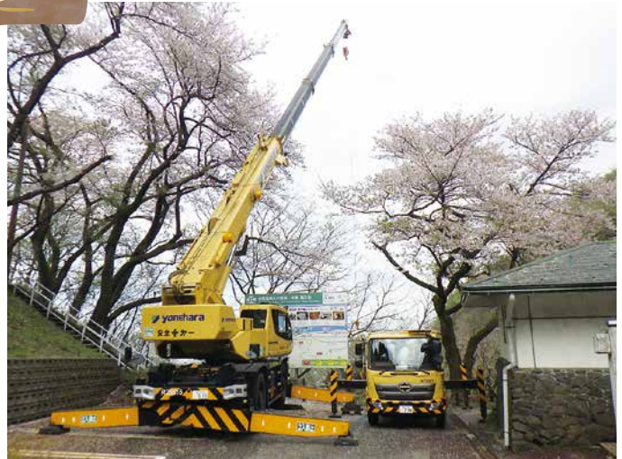
クレーン・高所作業車作業
