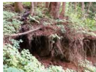
土砂流出状況
