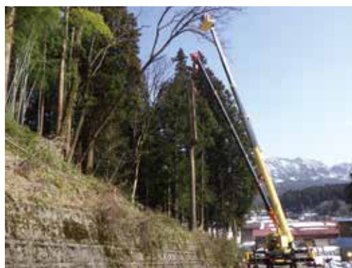
クレーン・高所作業車作業
